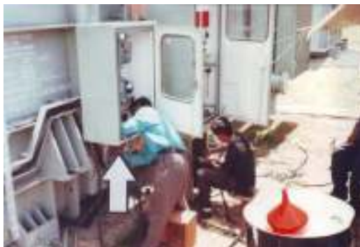
Gambar 15.3. Wiring Kabel Dan Penandaan Saluran Kabel
