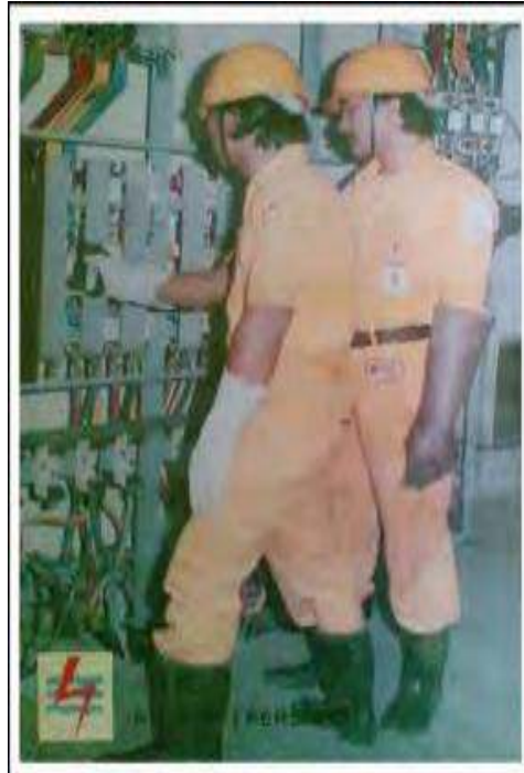
Gambar 14.26. Implementasi Pemakaian Sarung Tangan
