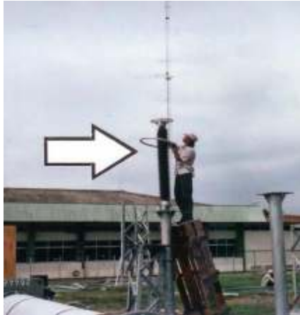
Gambar 15.7. Lightning Arrester (La)
