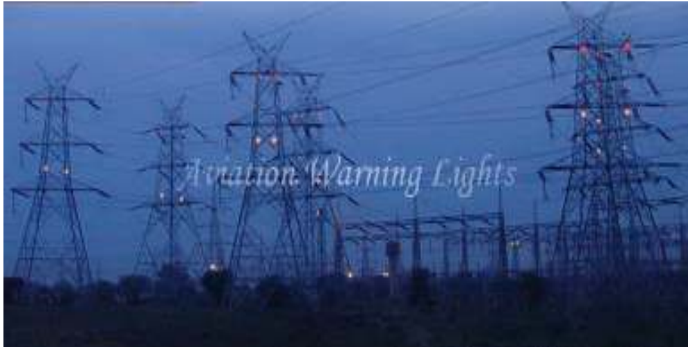
Gambar 14.8. Lampu Penerbangan Tower
