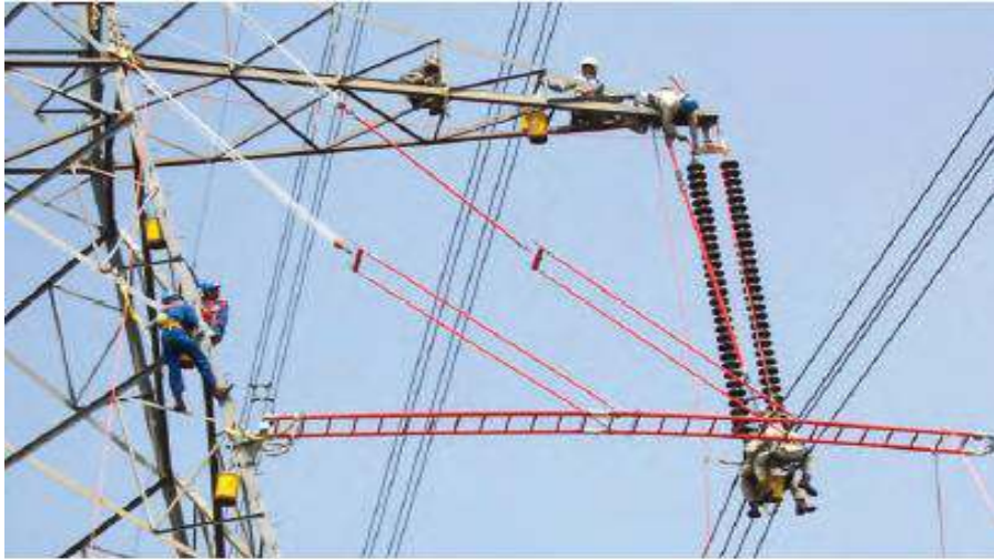
Gambar 14.1. Pekerjaan Dalam Keadaan Bertegangan
